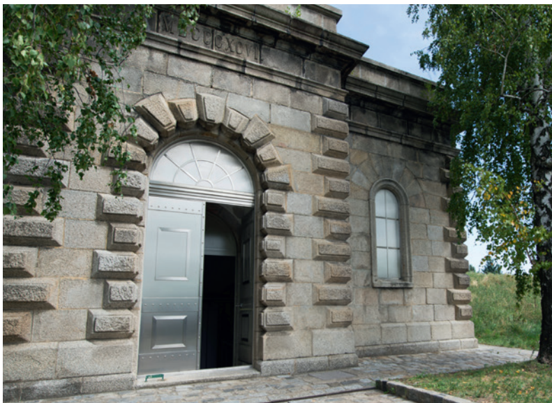
Foto: © Wiener Wasser / Novotny
